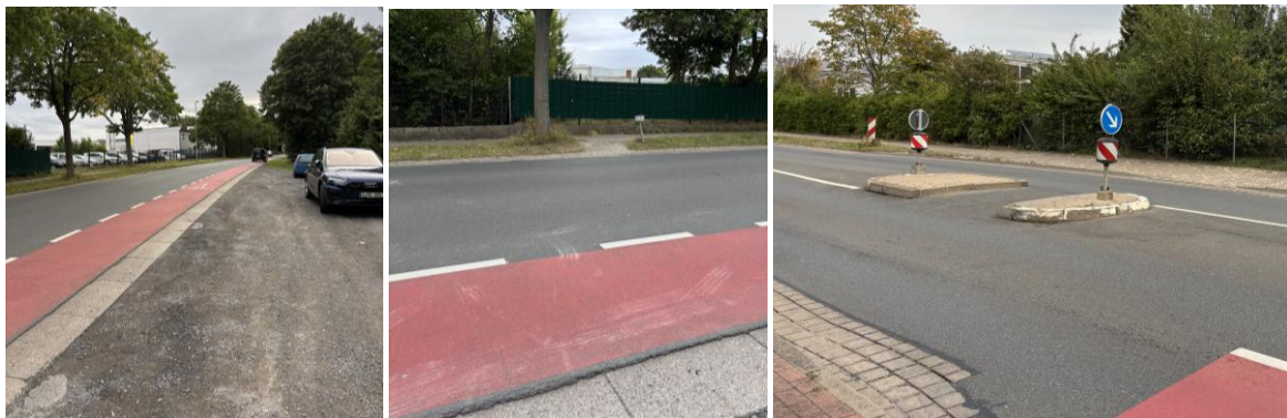
Abbildung 7: fehlende Querung und fehlender Gehweg beim Ausgang des Abenteuerspielplatzes Klein Basche (links und mittig) und Mittelinsel auf Höhe des Langenäckers (rechts)
