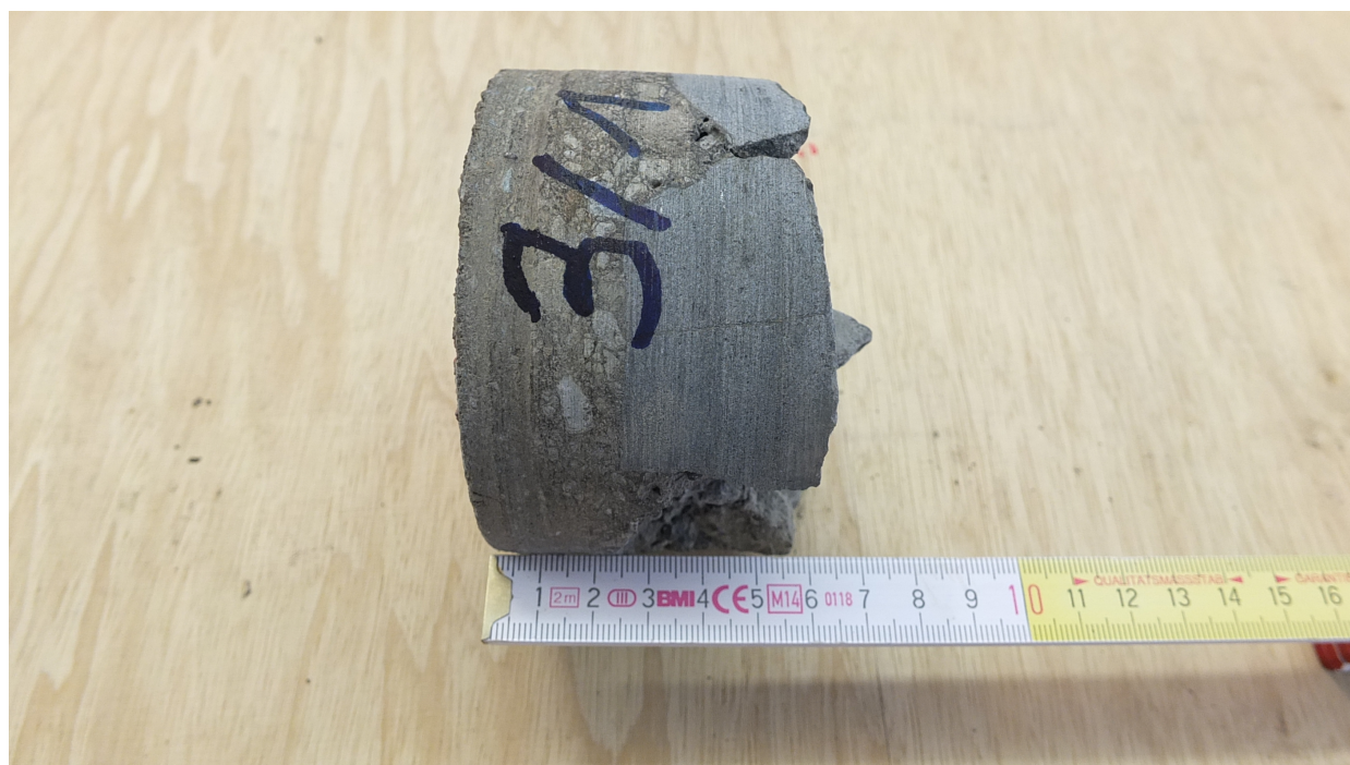
Abb. 3: Asphaltkern BS 3 (Bauwerk), d = 0,025 m über angespritztem Schotter
