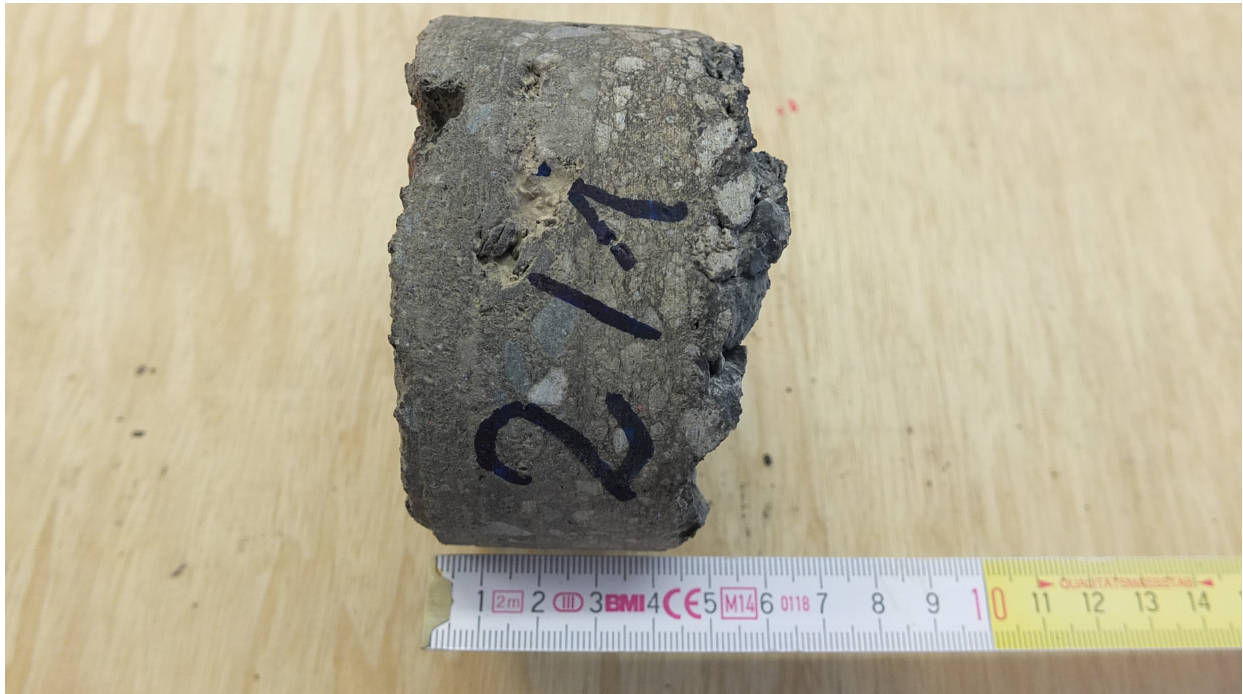
Abb. 2: Asphaltkern BS 2 / d = 0,04 m
