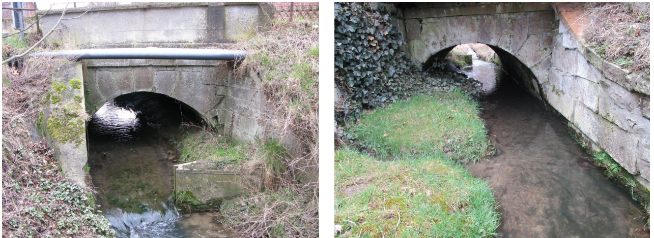
Abb. 1: Ansicht Bestand; Blickrichtung nach Norden (links) und Süden (rechts)
